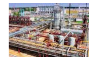
Белорусский газоперерабатывающий завод, Республика Беларусь
