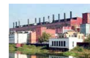
Челябинская ГРЭС, г. Челябинск
