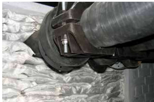
Закладка проема противопожарными подушками
