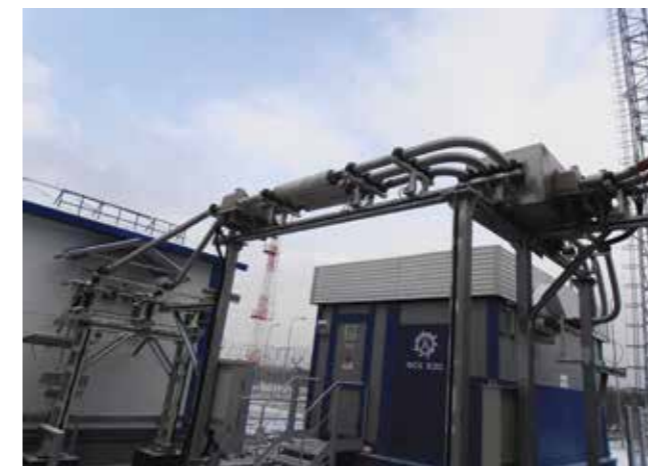
Подключение к разъединителю
