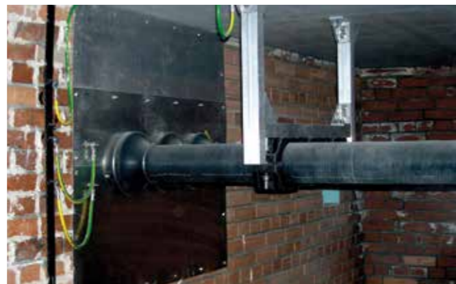
Заделка проема металлическими плитами
