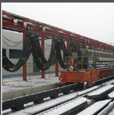
Подвесная система на вагоноопрокидывателе, Китай
