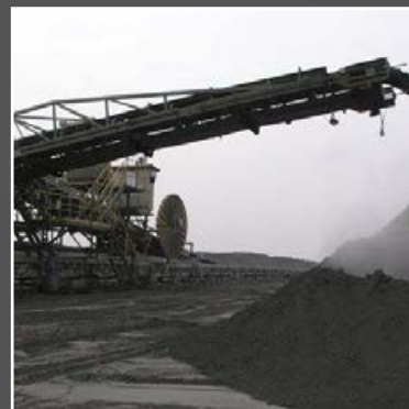
Приводной кабельный барабан на Стакере, Чехия
