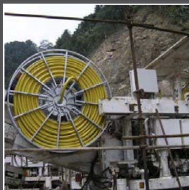
Приводной кабельный барабан на туннелепроходческой машине, Индия
