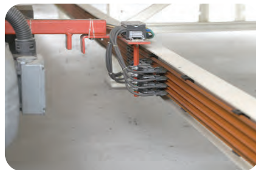
Пример установки токосъемника
