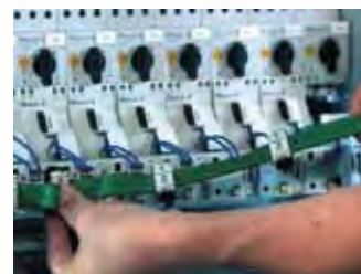
Надежная установка и электромонтаж
