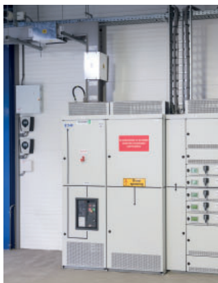
Распределительное устройство Eaton Capitole 20 для подачи питания в шинопроводы Power Xpert® XP и Power Xpert® MP
