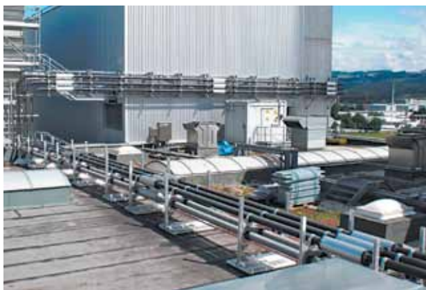
Сдвоенная трасса DURESCA 12 кВ DE 3150 А, DG 4500 А
