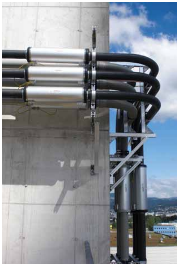
DURESCA 12 кВ 3150 А, 4000 А Крепление секций к стене
